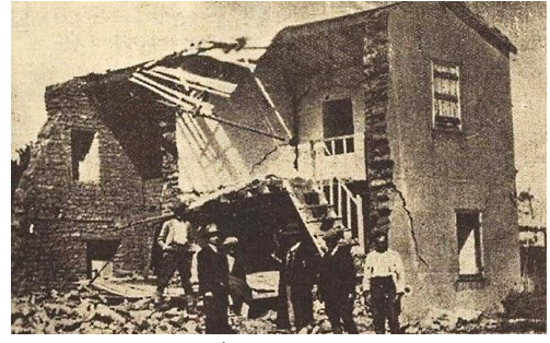
Resim 2. Torbalı, İzmir depremi, yıkılan konut binası (Kaynak: http://www.bizimtorbali.com ).
